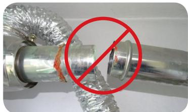
• **确认锅炉排气筒是否脱落**
